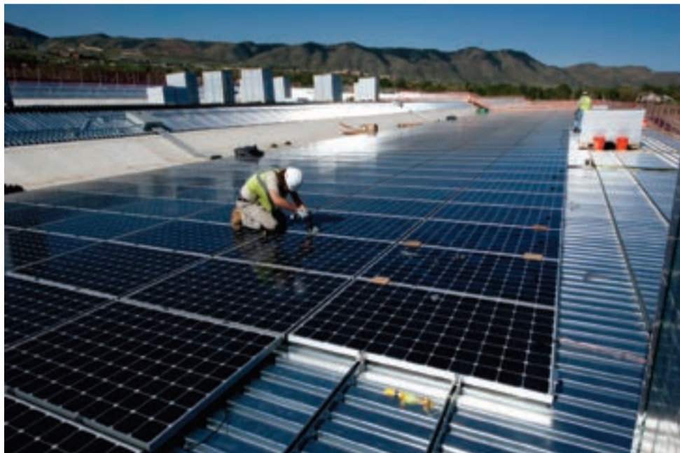
Instalación de placas solares en la cubierta de una empresa | Imagen cedida por Ecovatios
